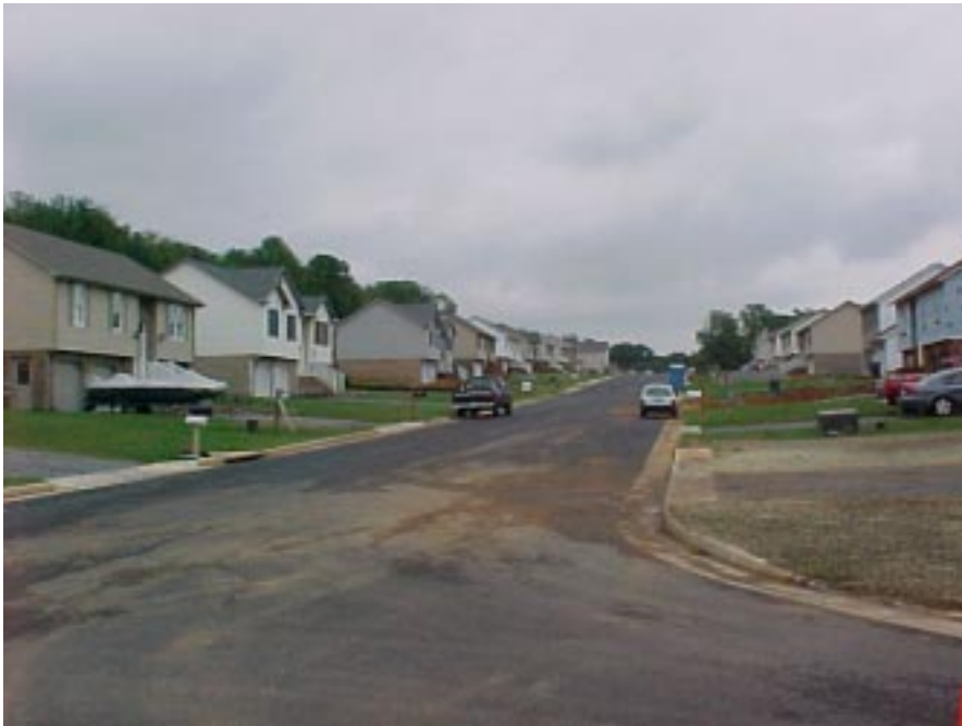
Garst Farms, new subdivision
